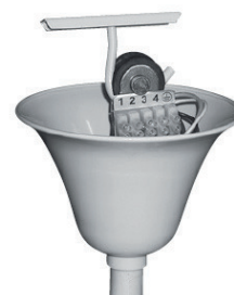
detail zavěšení s izolátorem chvění, závěs je vhodné doplnit o pojistné lanko
